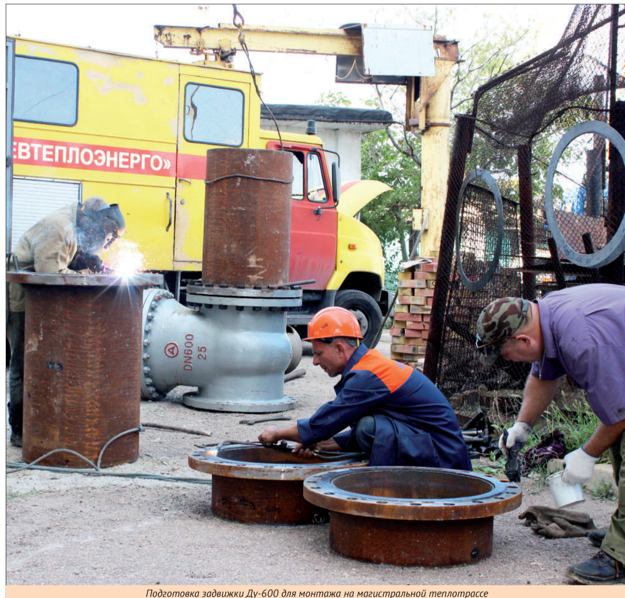
Подготовка задвижки Ду-600 для монтажа на магистральной теплотрассе
