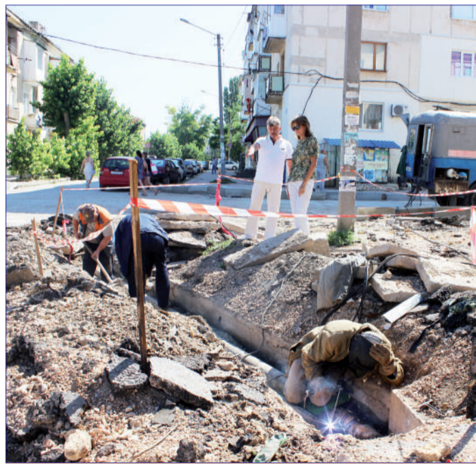
Ремонт теплотрассы на ул. Рабочая, 22
