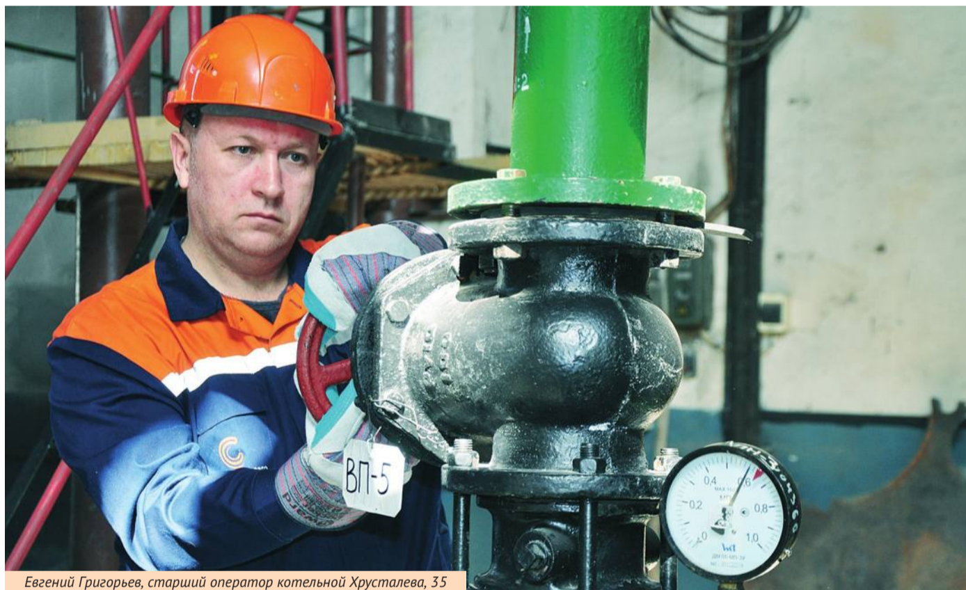
Евгений Григорьев, старший оператор котельной Хрусталева, 35
