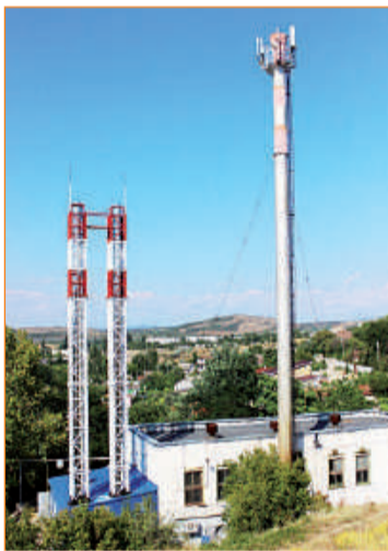
БМК, ул. Терлецкого, 15
