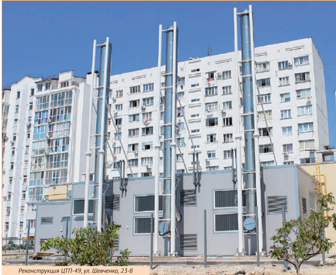
Реконструкция ЦТП-49, ул. Шевченко, 23-б
