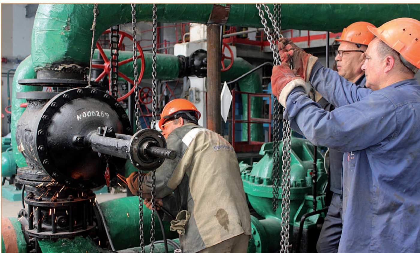
Ремонтные работы на котельной ул. Хрусталева, 66-а
